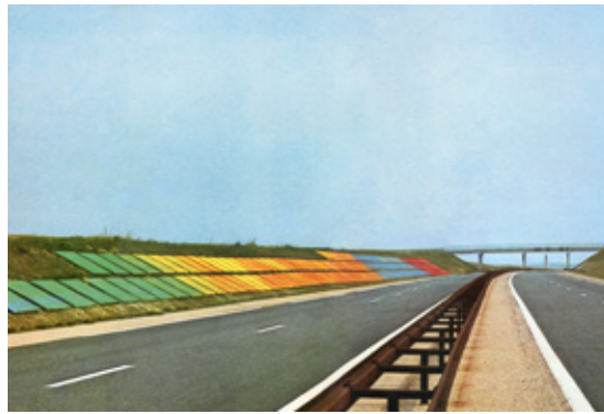
« Environnement pour une autoroute », 1977
